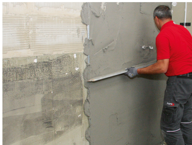
Anschließend den Putz mit einer Latta über die Putzschienen sauber von unten nach oben abziehen.
