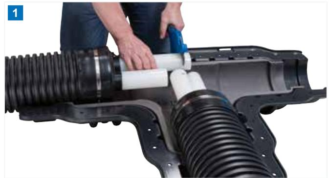
1 Längen Sie das Mediumrohr rechtwinklig auf die passende Länge ab und stecken Sie anschließend den Q&E-Ring auf das Rohrende.
