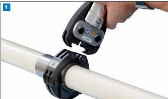
1 Das entgratete Verbundrohr bis zum Anschlag in den Fitting einstecken. Dann passende Pressschlinge (gleiche Dimension und gleicher Farbcode wie Fitting) bis zum farbigen Anschlag um die Presshülse legen.
