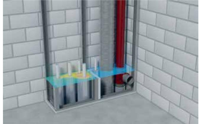
*Thermisch getrennt verlegte kaltgehende Trinkwasserleitung (PWC) in einem Installationsschacht zur Vermeidung einer unzulässigen Erwärmung*
