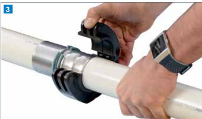
3 Nach dem Verpressen ist die erfolgreiche Verpressung durch eine deutliche Verformung der Presshülse sichtbar (Sichtkontrolle).
