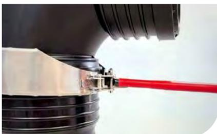
Mithilfe eines Schraubendrehers als Hebelarm die LKS-Schelle fest verschließen.
